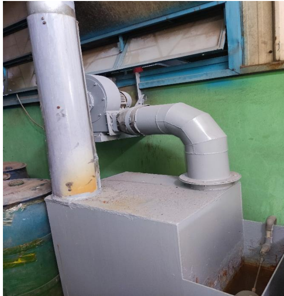
Hình 3. 10. Hình ảnh HTXL bụi phòng đóng gói thuốc WG, WP
