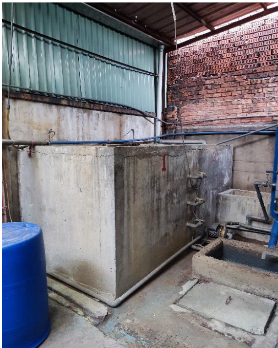
Hình 3. 4. Hình ảnh HTXL nước thải sản xuất công suất 3 m 3 /ngày của cơ sở
