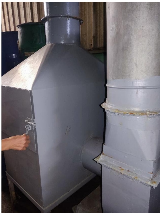
Hình 3. 7. HTXL khí thải khu vực phối trộn, chiết rót
