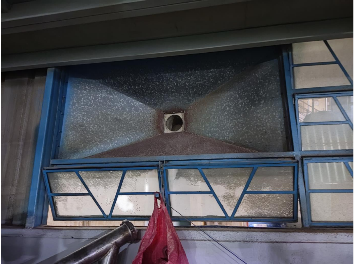
Hình 3. 8. Chi tiết hệ thống thu gom bụi từ phòng đóng gói
