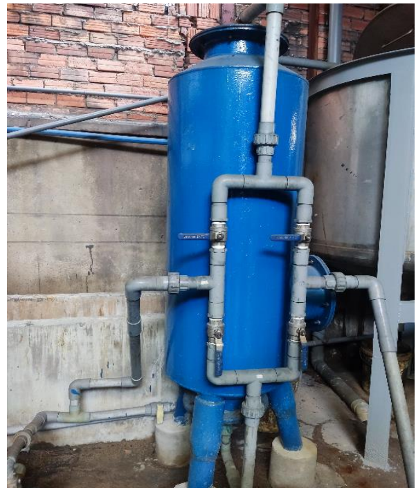
Hình 3. 4. Hình ảnh HTXL nước thải sản xuất công suất 3 m 3 /ngày của cơ sở
