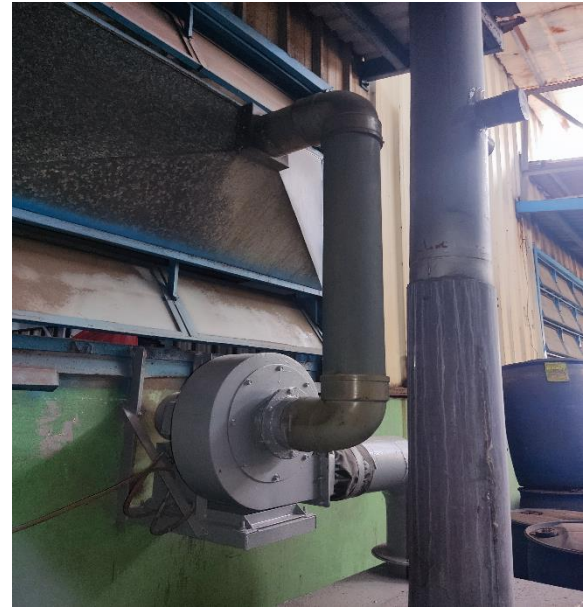
Hình 3. 10. Hình ảnh HTXL bụi phòng đóng gói thuốc WG, WP
